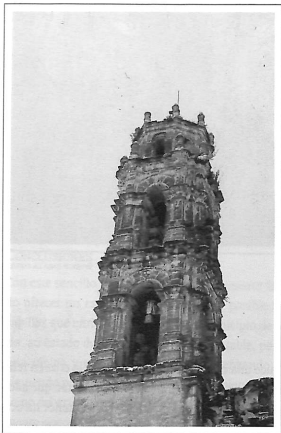
DETALLE DE LA TORRE
